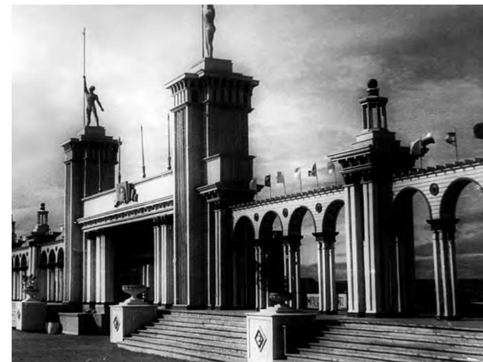
Трибуны стадиона «Динамо». Архитектор Л. Д. Сомин. г. Воркута. 1946 г.
