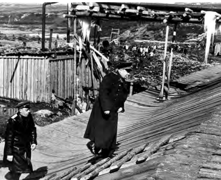
Начальник комбината «Воркутуголь» М. М. Мальцев и В. Д. Меркурьев посещают плотину ТЭЦ-1 во время реконструкции. г. Воркута. 1945 г.
