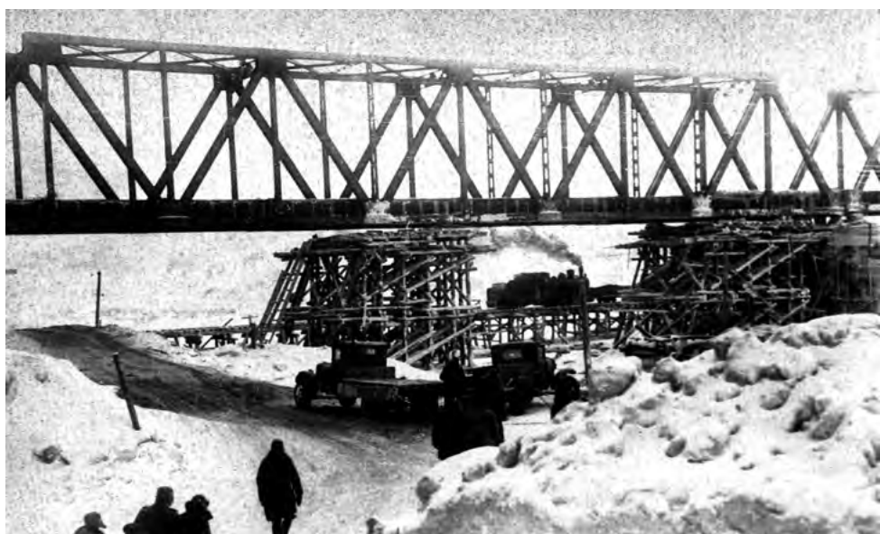
Строительство нового железнодорожного моста широкой колеи через реку Воркуту. 1943 г.
