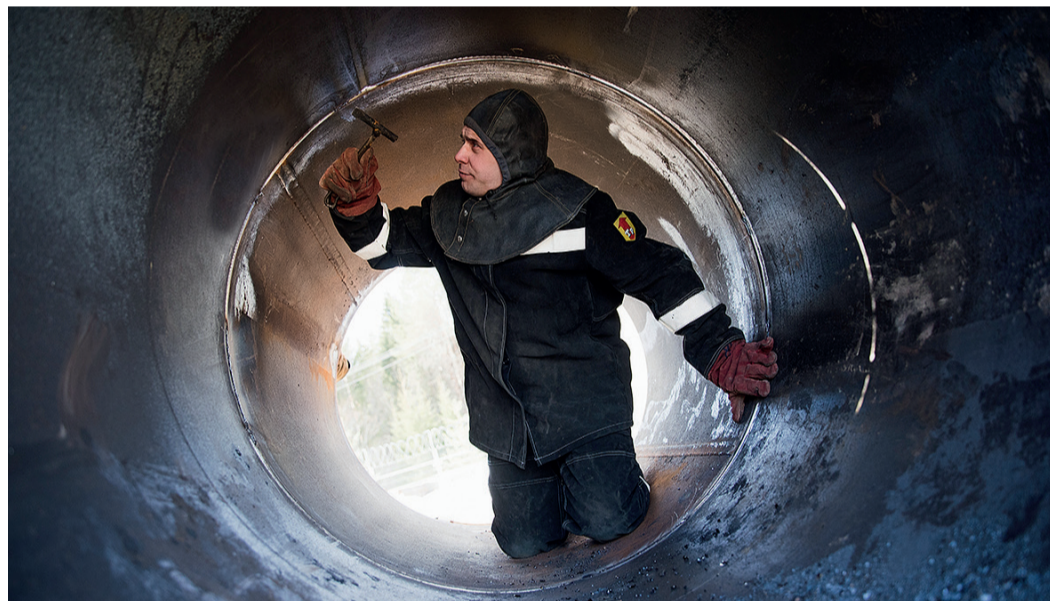
Алексей проводит визуальный контроль качества выполнения подварочного слоя шва
