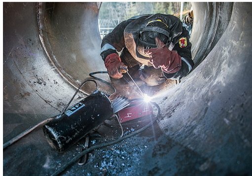
Выполнение подварочного слоя шва – процесс, который выполняется после корневого слоя шва
