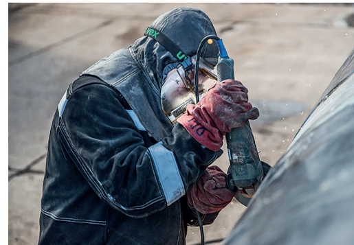
Послойная зачистка сварного соединения шлифовальной машинкой
