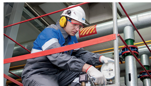
Установка контрольно-измерительных приборов
