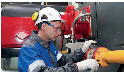
Протяжка запорной арматуры технологического оборудования
