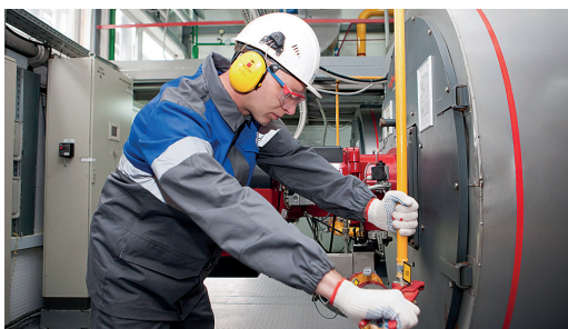
Замена запорной арматуры на технологическом трубопроводе
