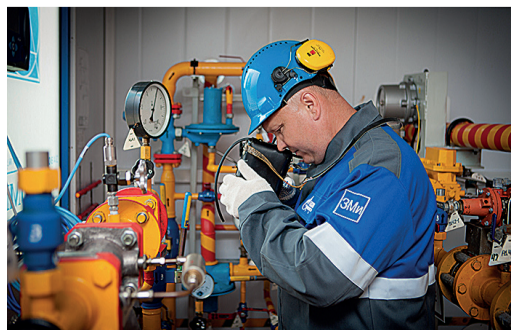
Проверка отсутствия загазованности газоанализатором
