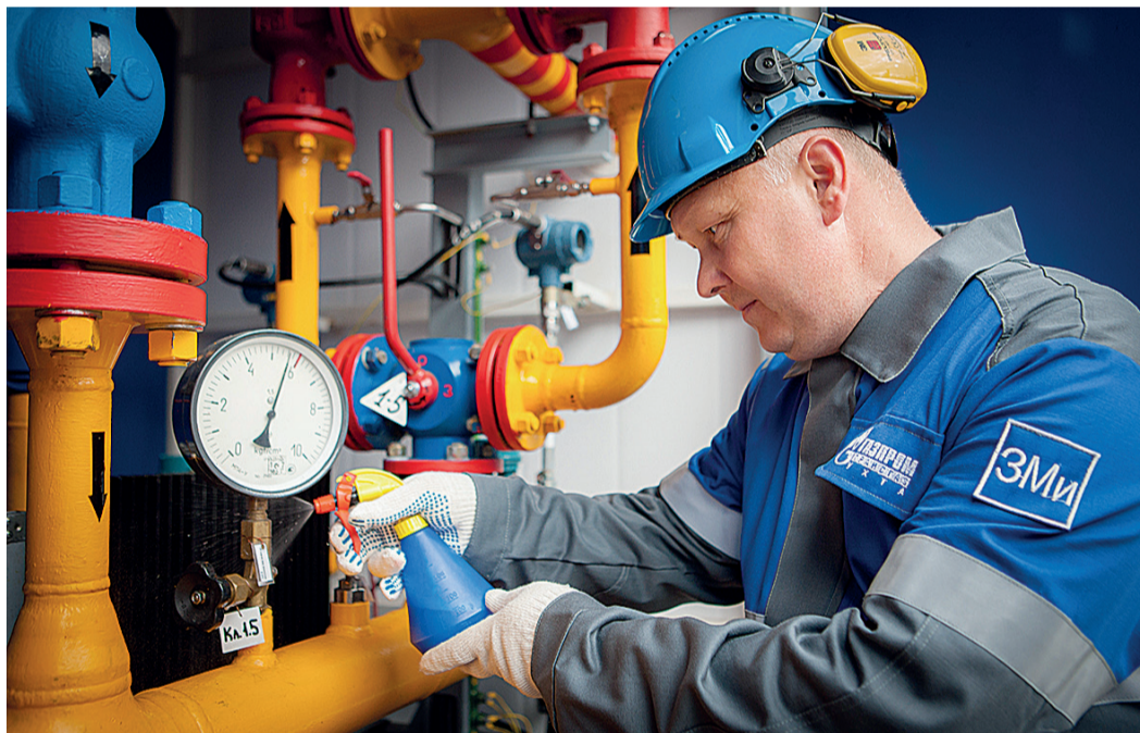
Проверка герметичности резьбовых соединений пенообразующим раствором
