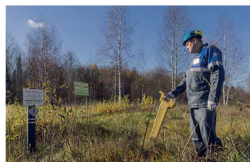
Определение трассы кабеля на местности
