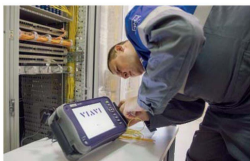
Подготовка к измерению волоконно-оптического кабеля
