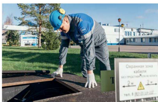
Осмотр линейно-кабельных сооружений
